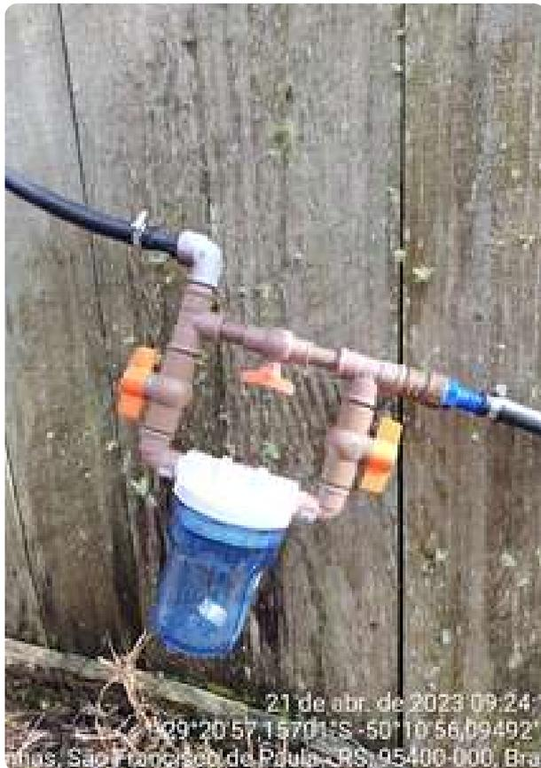
Clorador instalado entre o ponto de captação e a caixa de água
