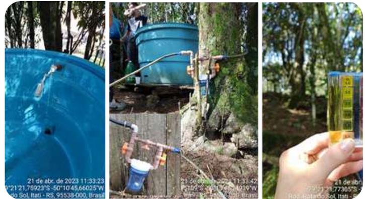
Limpeza de caixas d'água e instalação de cloradores.
